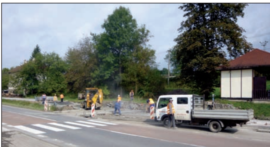
Výstavba chodníků pod nádražím.
