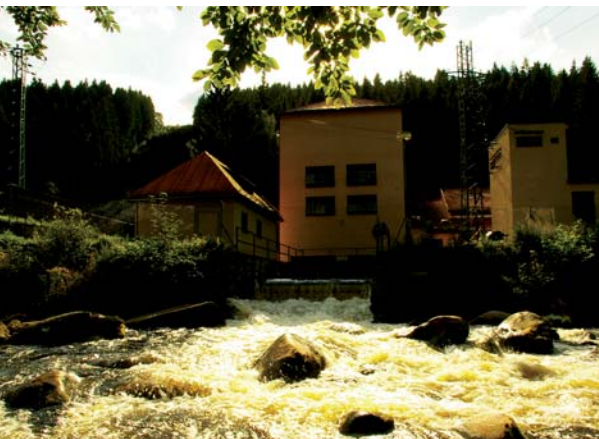
Voda opouštějí turbíny elektrárny Vydra
