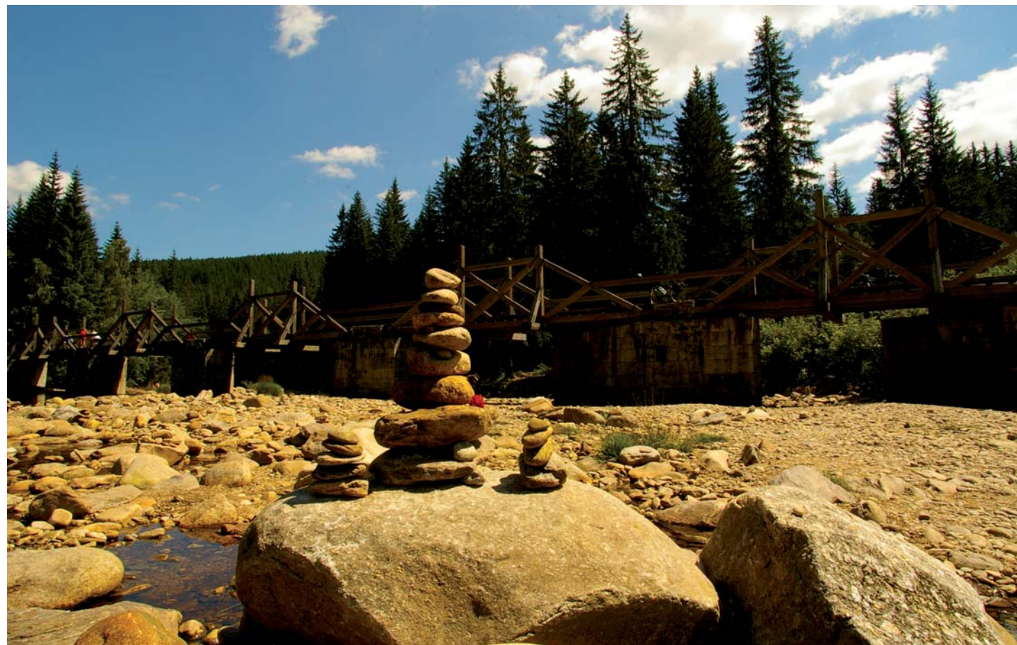
I za slabých letních průtoků odvádí Hradlový most vody z řečiště Vydry do kanálu
