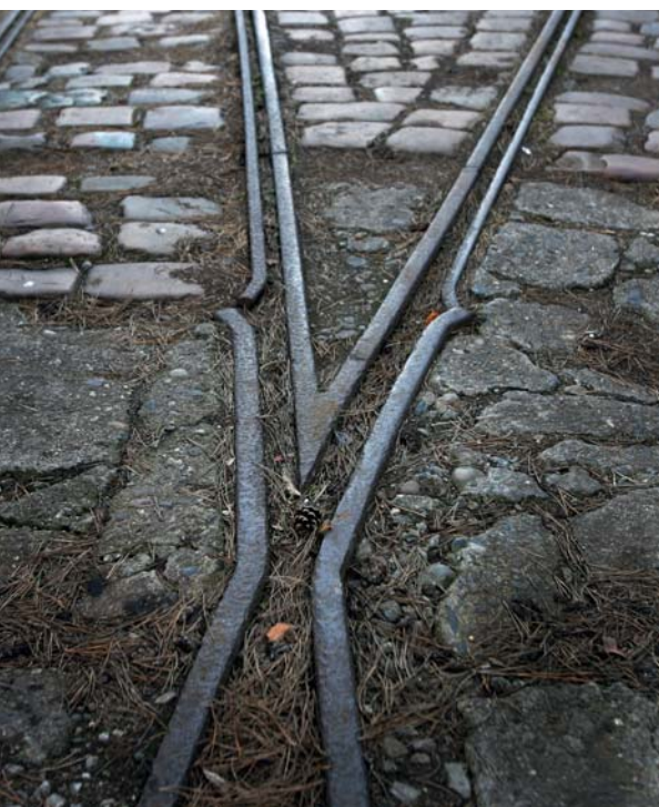
Vše zůstalo zachováno – včetně mohutných kolejnic
