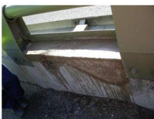
Opravy betonu poškozeného solí
