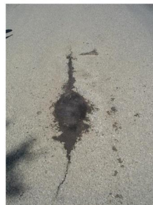
Oprava výtluků i na dlažbě a betonu
