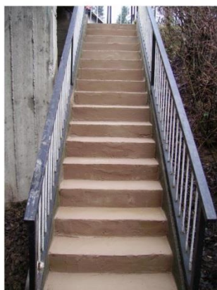
Oprava schodů při mínus 9 st. C
