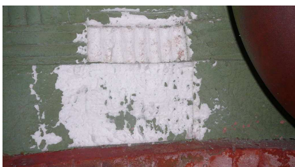
Stav po montáži nových segmentů
