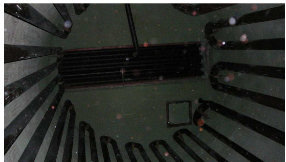
Pohled na strop pece
