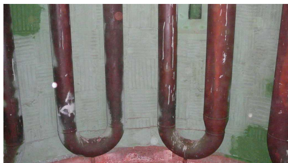
Stav po provedení nástřiku
